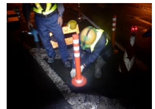
（道路附属物工事）
