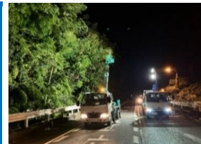
（維持修繕工事）
