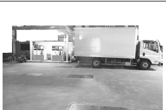
写真2 破損した固定注油設備のキャノピー
