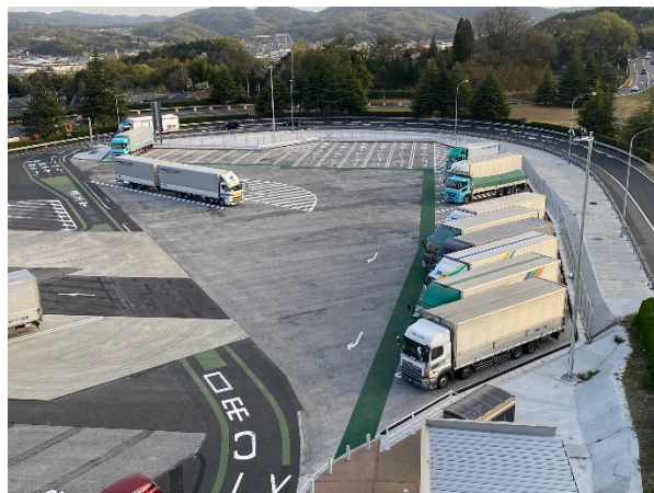
拡張した大型車エリア(E2 山陽道 福山 SA(下り)) ※2021年4月時点(一部箇所工事中)
