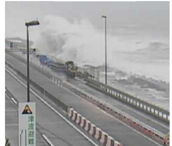
令和元年9月 神奈川県大磯町 国道1号
