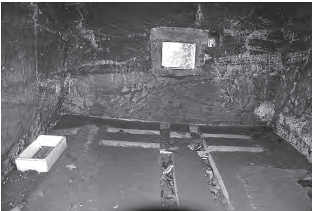
三浦半島・三戸海岸の洞窟陣地 陣地内部からみた開口部と床の機関砲を設置した土台跡
