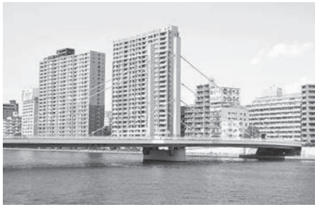
ビルの裏側に「安宅丸由来碑」がある
