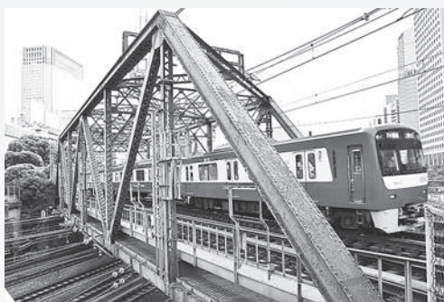
消えゆく線路橋
