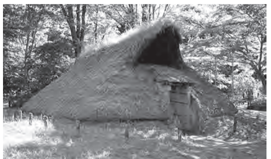
縄文前期の竪穴住居(復元/縄文の村) 地面を掘り下げて柱を立て、その上に屋根を葺いている
