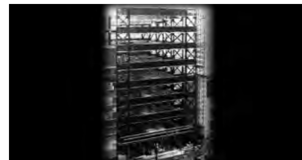
建設が進む東京都トラック総合会館
